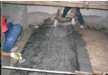
El refuerzo realizado con **C-MESH** satisface plenamente las expectativas del diseñador de estructuras desde el punto de vista de las prestaciones y de la adherencia al soporte. Este tipo de refuerzo **mantiene la capacidad de transpiración normal y la compatibilidad química** aún con estructuras de gran valor histórico-artístico.
