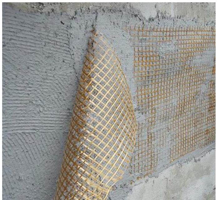
**Figura 1 - Sistema FRCM di Ruregold composto da rete PBO-MESH 22/22 e matrice inorganica MX-PBO Muratura.**
