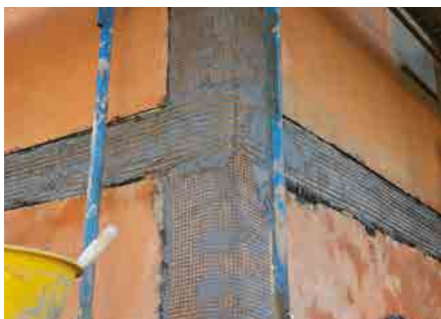
Rinforzo di cantonali e cordoli di piano.
