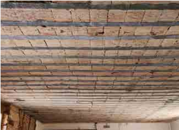
Ripristino del calcestruzzo.
