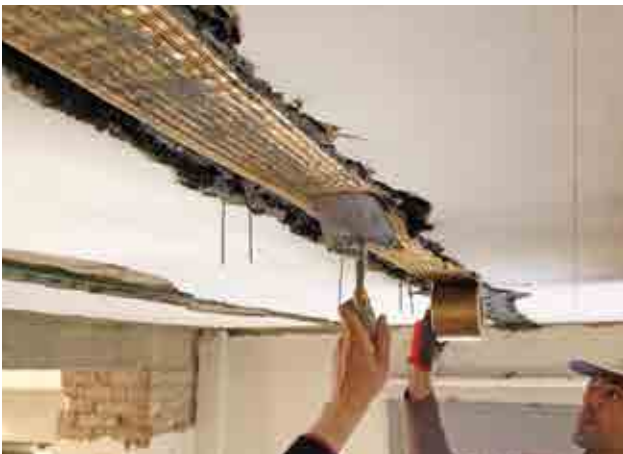
Applicazione del sistema di rinforzo FRCM.
