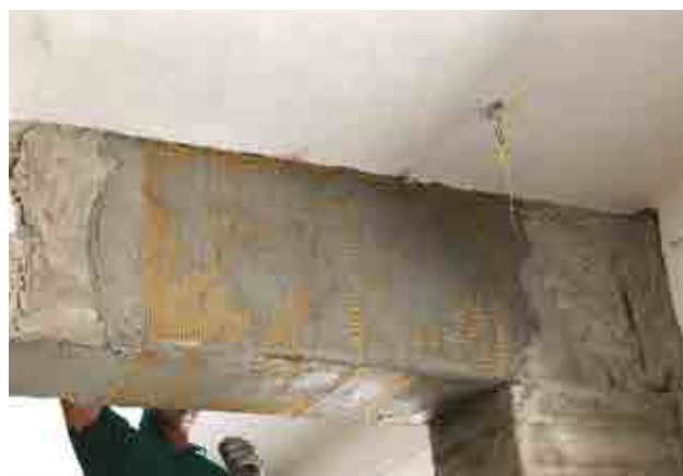
Rinforzo a taglio.
