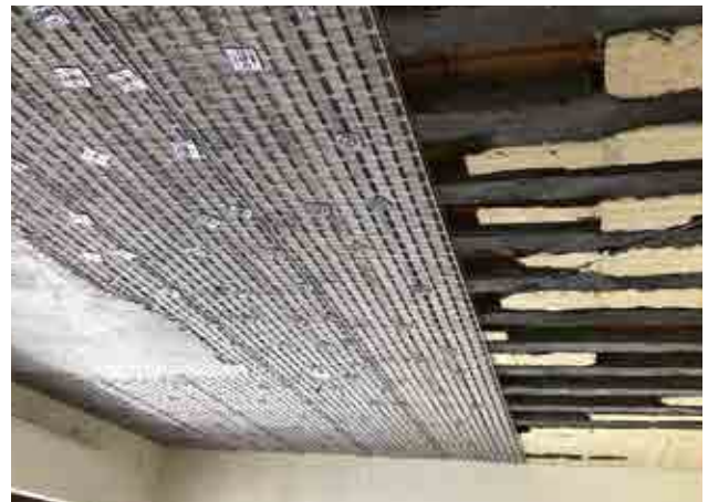
Applicazione del sistema antisfondellamento STUCANET.
