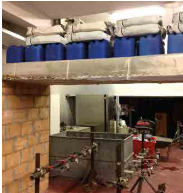
Prove di carico sistema STUCANET.
