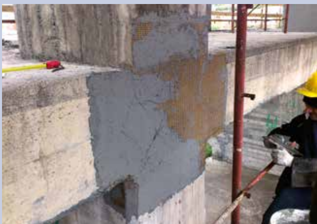
Incremento della resistenza a taglio del pannello di nodo.
