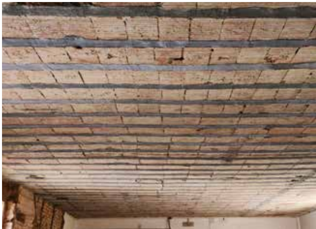
Ripristino del calcestruzzo.
