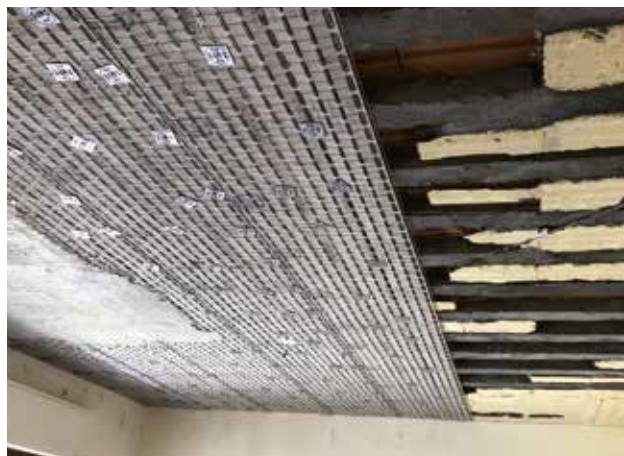
Applicazione del sistema antisfondellamento STUCANET.
