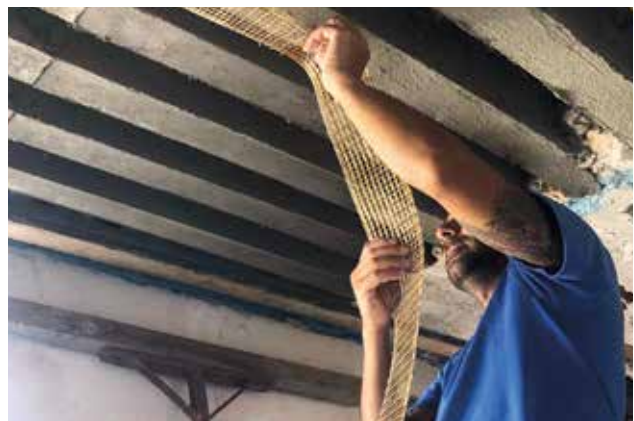
La seconda fase prevede la ricostruzione geometrica del travetto con la malta da ripristino strutturale MX-R4 Ripristino
