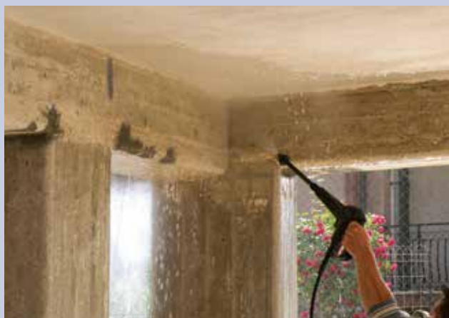
Bagnatura del supporto a rifiuto.
