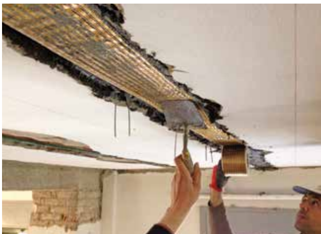
Applicazione del sistema di rinforzo FRCM.
