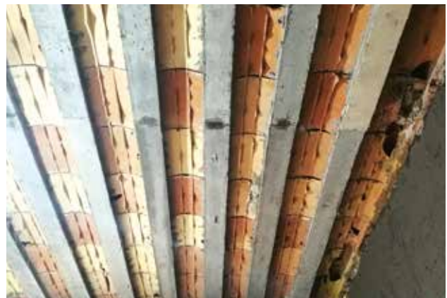
La seconda fase prevede la ricostruzione geometrica del travetto con la malta da ripristino strutturale MX-R4 Ripristino
