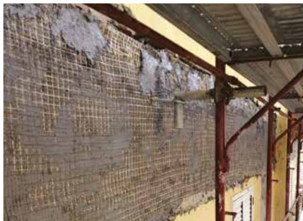
Applicazione del sistema FRCM.
