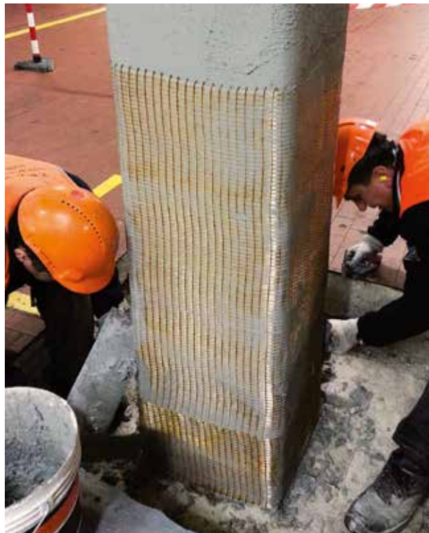
Rinforzo a taglio e confinamento di un pilastro.
