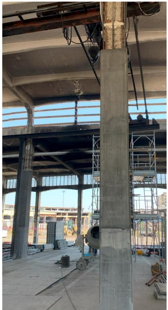
Figura 1 - Ringrosso (jacketing) di pilastro mediante MICRO GOLD STEEL.
