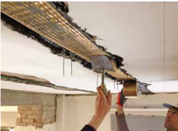
Applicazione del sistema di rinforzo FRCM.
