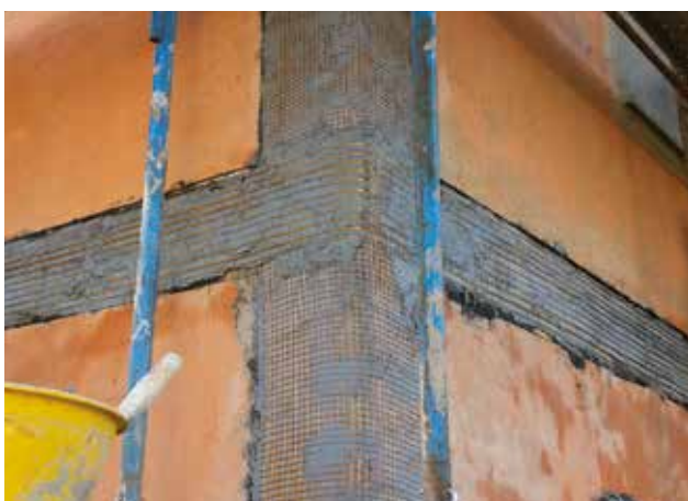
Rinforzo di cantonali e cordoli di piano.
