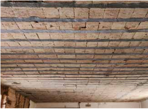
Ripristino del calcestruzzo.
