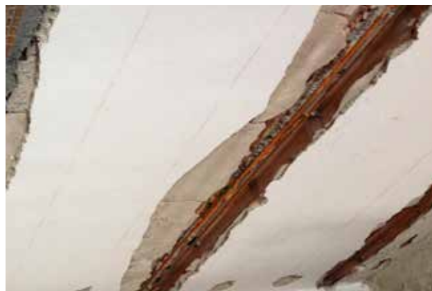
La prima fase di intervento prevede la rimozione delle parti incoerenti del travetto in calcestruzzo, pulizia e passivazione dei ferri di armatura.
