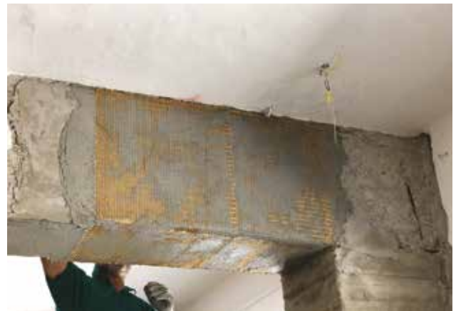
Rinforzo a taglio.
