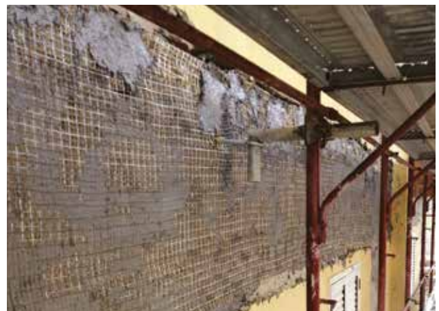
Applicazione del sistema FRCM.
