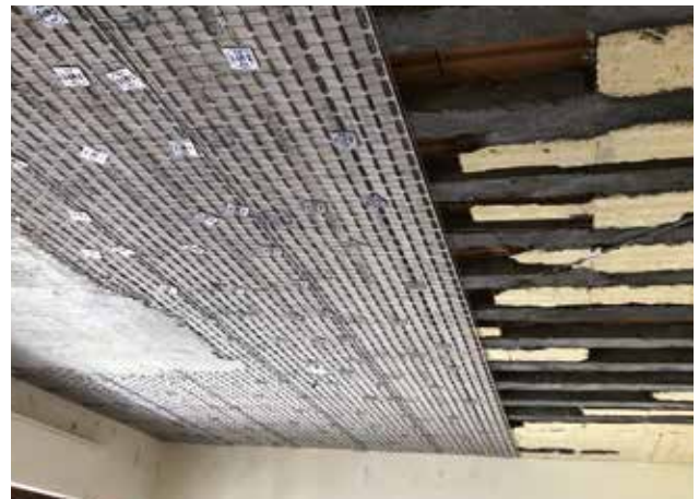
Applicazione del sistema antisfondellamento STUCANET.
